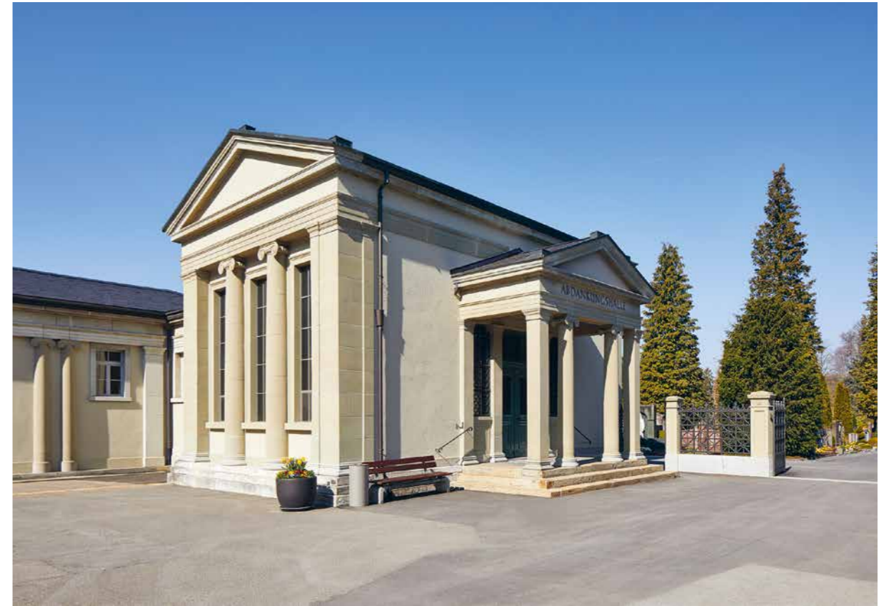
Abdankungshalle beim Haupteingang, Innenansicht siehe S. 12.
